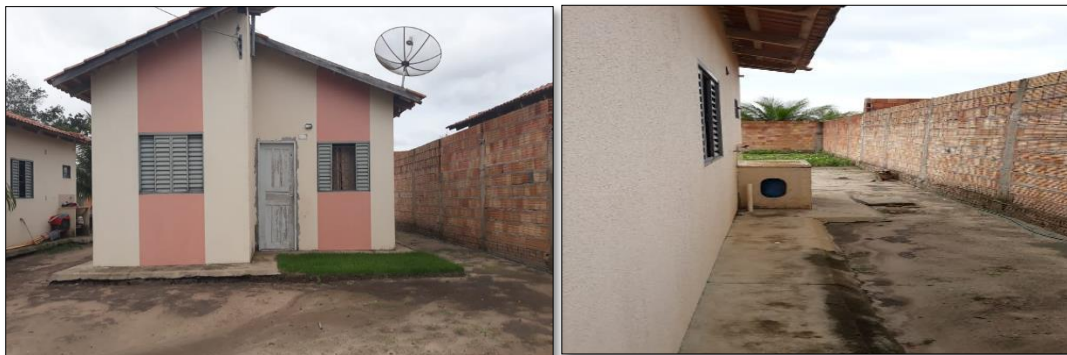
Figura 3. Faixada aérea externa dos serviços domésticos nos domicílios do Residencial Tiradentes, Marabá, PA, 2018.
